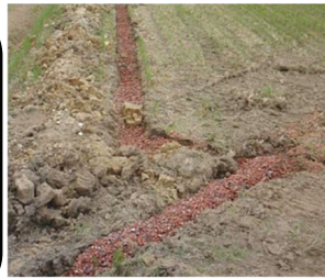
施工イメージ(暗渠) (山形県HPより引用)
