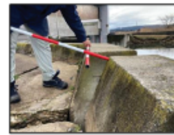
【和倉海岸】 堤防の傾斜
