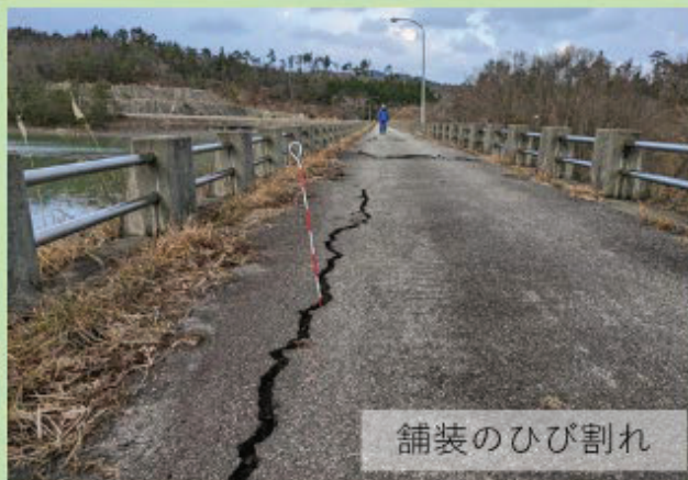
地震後のダム堤体の被災状況
