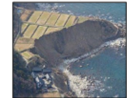
【輪島海岸】 堤防の倒壊及び背後法面の崩壊
