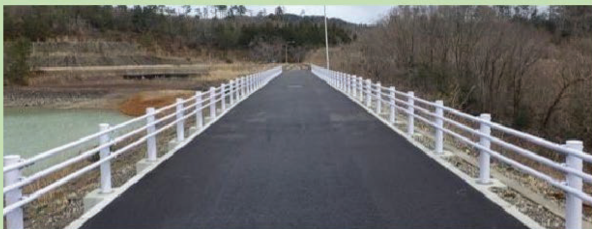
ダム堤体の復旧工事の完成
