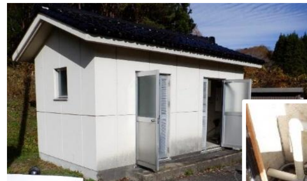
小規模水道施設 (ポンプ場)
