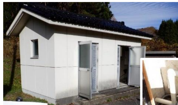
小規模水道施設 (ポンプ場)
