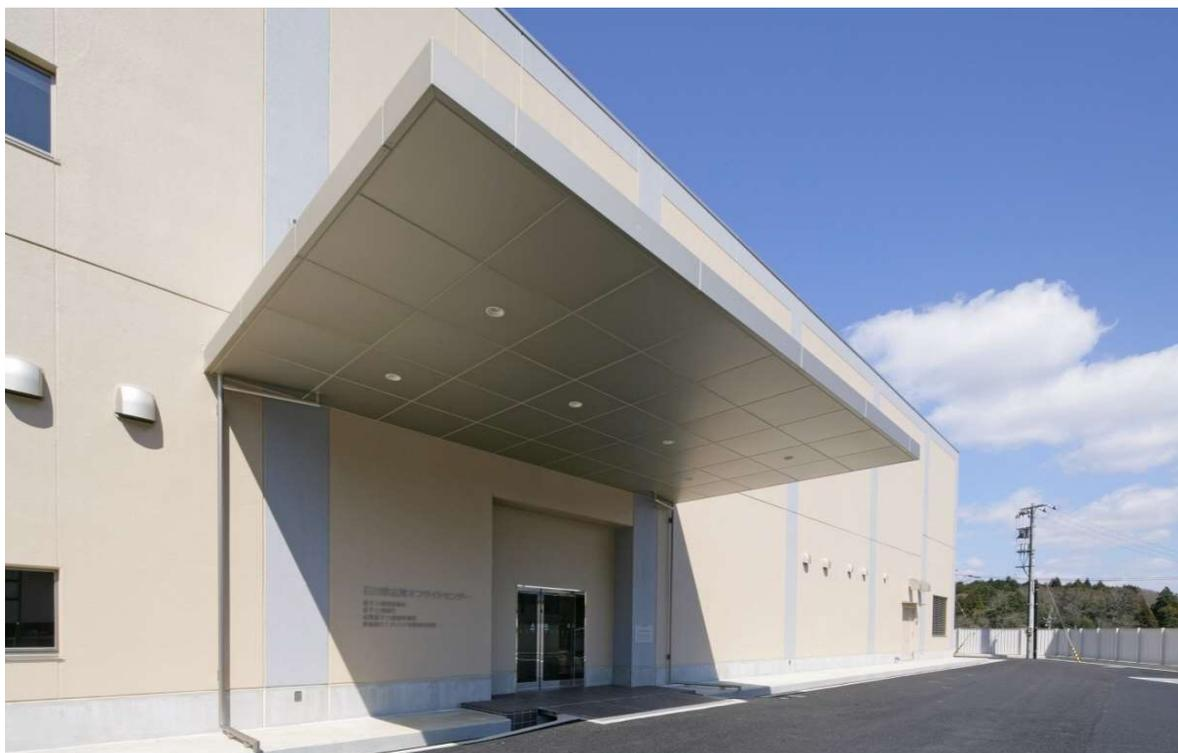
**災害に強い施設** 建物は免震構造を採用し大地震から建物を守り、想定される停電、断水等の際も稼働できるように、バックアップ付の自家発電設備、無停電電源装置飲料水タンク、中水、汚水タンクを備えている。
