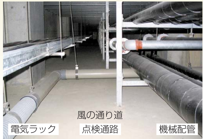
トレンチ内部
