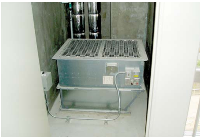
給気シャフト内部
