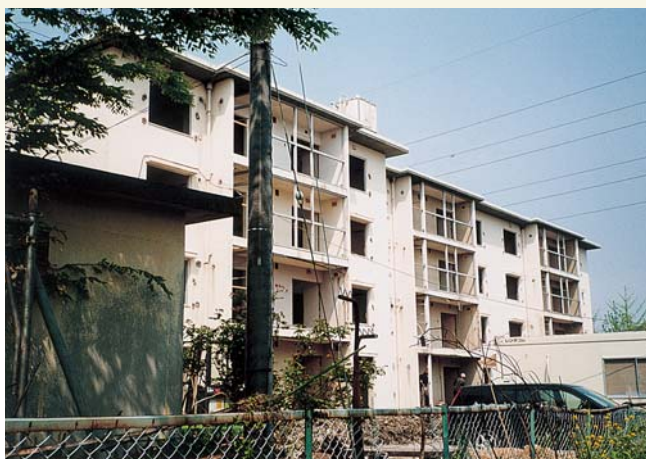
躯体を残した状況
