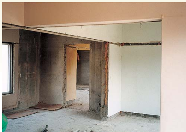
内部解体状況
