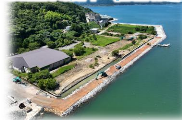
和倉温泉護岸（復旧箇所）
