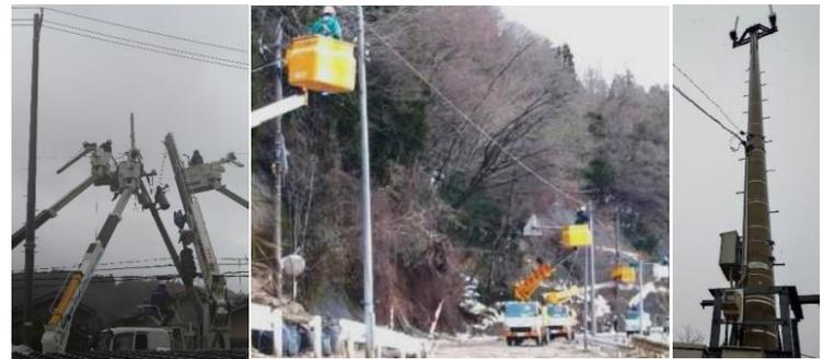
商用電源の復旧 (北陸電力送配電)    光ファイバの張替 (NTT西日本)    基地局の修理 (NTTドコモ)
