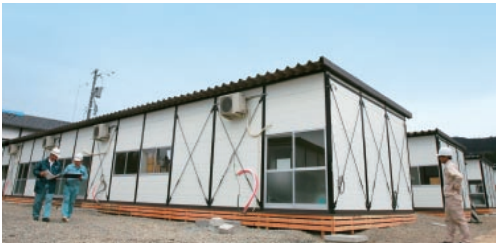
完成間近の仮設住宅 =4月15日、輪島市門前町館
