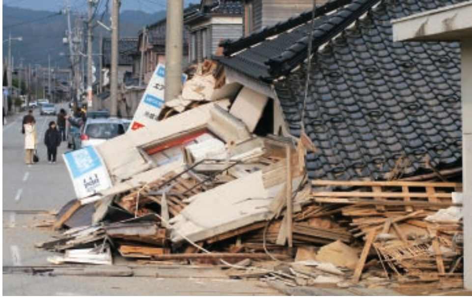
倒壊した商店=3月25日、 輪島市門前町道下
