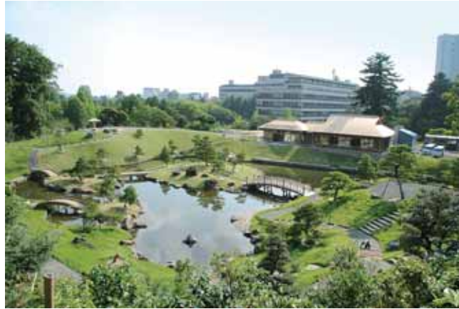
整備中の玉泉院丸庭園の様子
