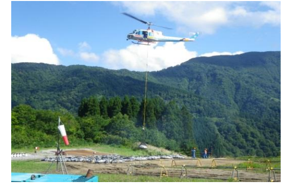
袋詰めした資材の積込
