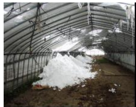
ハウスビニール切断
