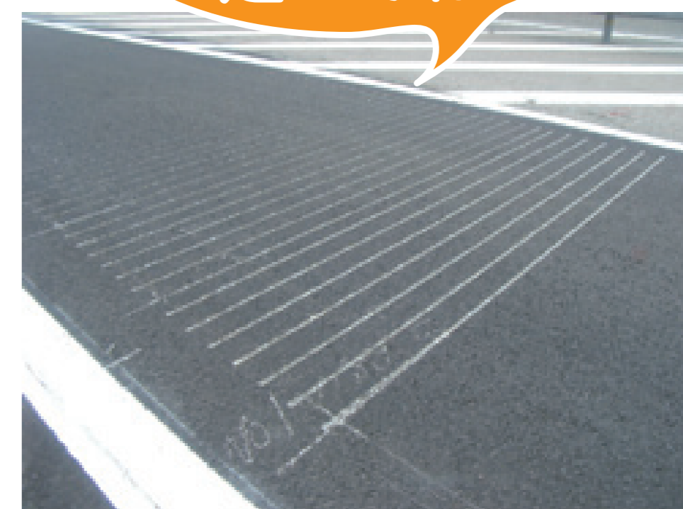
道路面に刻まれた溝
