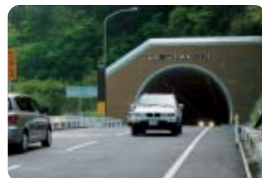
円滑なすれ違いが可能 (石川県側坑口)
