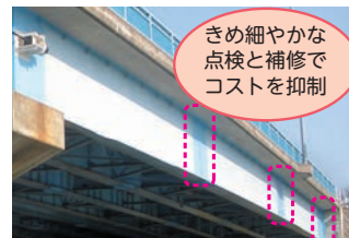
○現在の予防保全対策（部分塗装補修）
