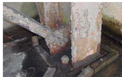
<柱の根本が腐食した例>
