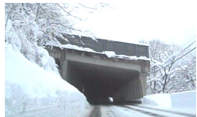
<コンクリート製のシェッド>
