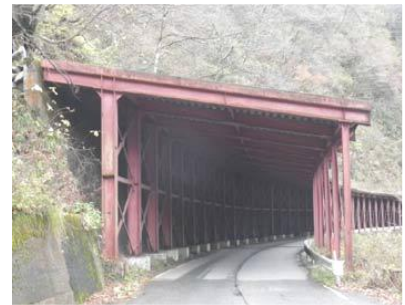
<鋼製のシェッド>
