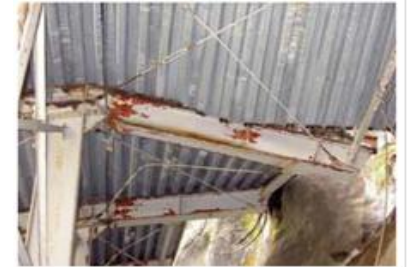
<落石で屋根が壊れた例>
