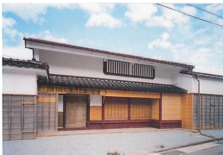
主屋正面外観
