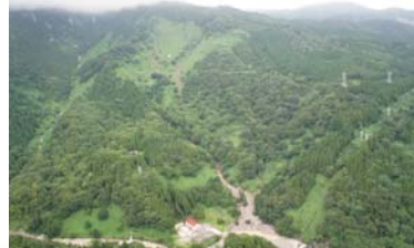
小滝川左支川田中川より土石流が発生し発電施設の一部が被災
