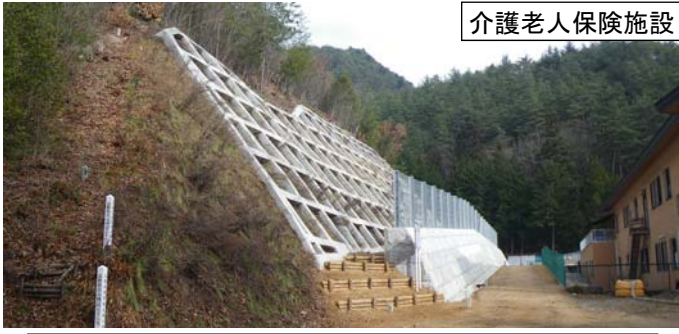
長野県安曇野市有明地区 急傾斜地崩壊防止施設 (重力式待受擁壁)
