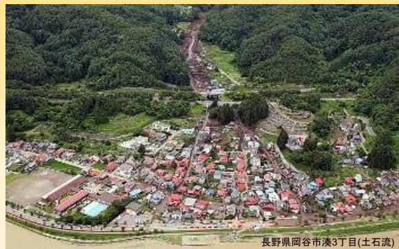
長野県岡谷市湊3丁目(土石流)
