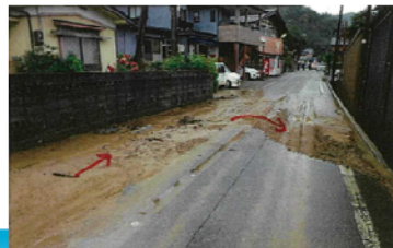
土砂水が住宅街へ流出(糸魚川市大字根小屋)
