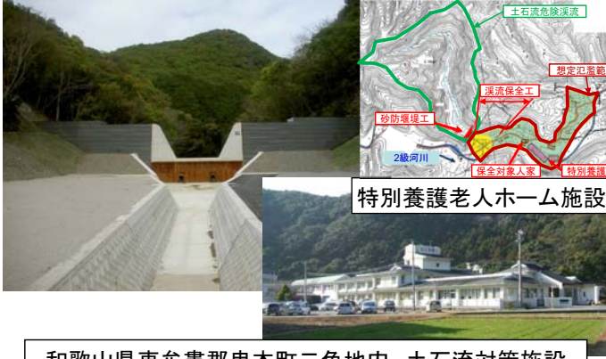
和歌山県東牟婁郡串本町二色地内 土石流対策施設 (砂防堰堤及び溪流保全工)
