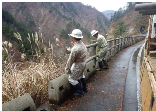
（ガードレール撤去）
