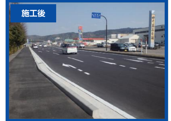
(加賀産業開発道路 野々市新庄2丁目 地内)
