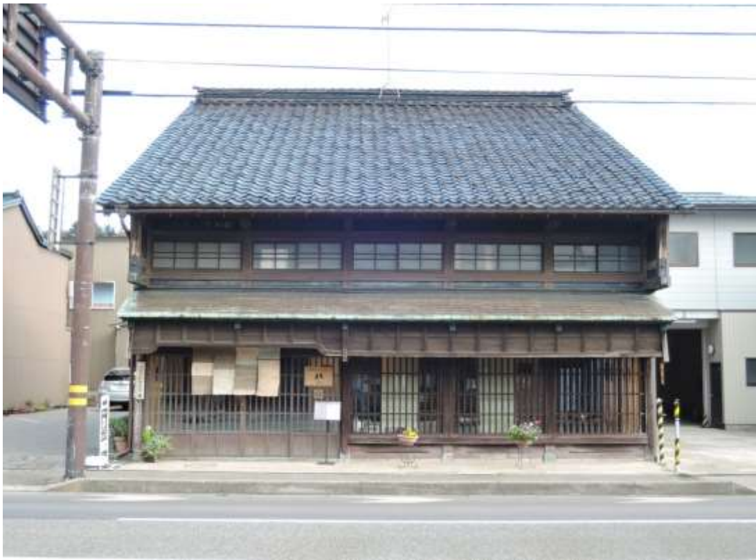
旧渡辺材木店店舗兼主屋 外観
