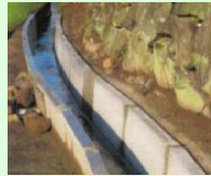
コンクリート水路の更新
