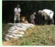
漏水箇所の補修
