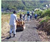
未舗装農道の舗装
