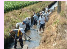
水路の泥上げ
