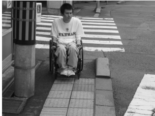
電柱でさらに狭くなった歩道
