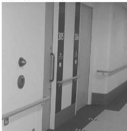
利用居室等に誘導する手すり
