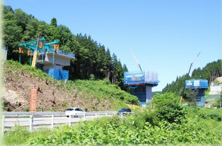
輪島道路（小泉高架橋）
