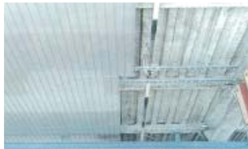
天井の囲い込み
