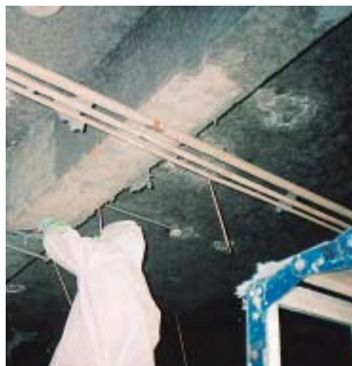
吹付け石綿の除去
