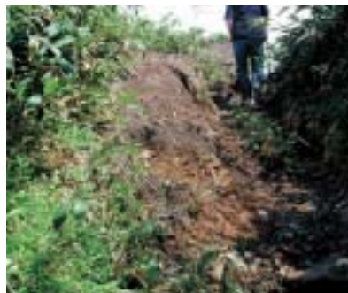
掘り込み 登山道が溝状に掘り込まれている
