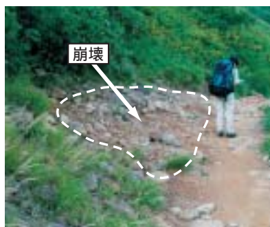
崩壊 登山道左側斜面上の裸地部分
