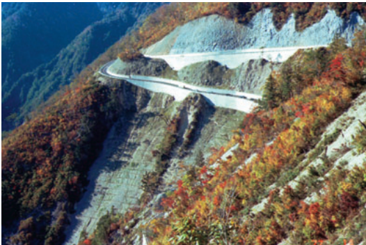
1977年の第2ヘアピン付近 (道路下の斜面に階段を切って、土が移動しないよう工事をしています。入り込んできた種子は発芽し、いつかは樹木も生えるようになります。)
