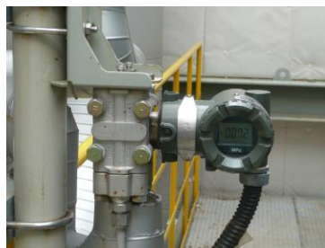
写真7 復水器入口蒸気圧力計
