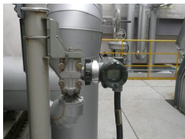
写真6 主蒸気ライン圧力計
