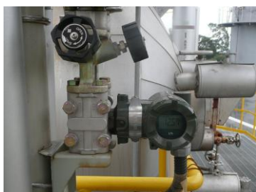
写真3 主蒸気ライン流量計
