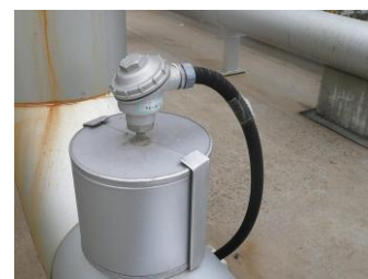
写真5 温水供給温度計
