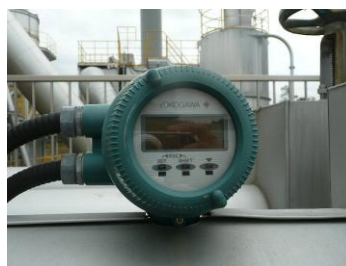
写真4 温水供給流量計
