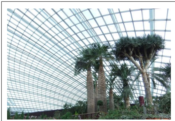
ガラス張りの天井部分
