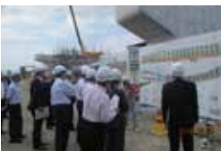
金沢外環状道路海側幹線を視察し、橋梁下部の工事について説明を受けました
