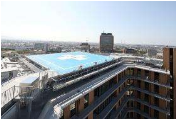
屋上ヘリポート
