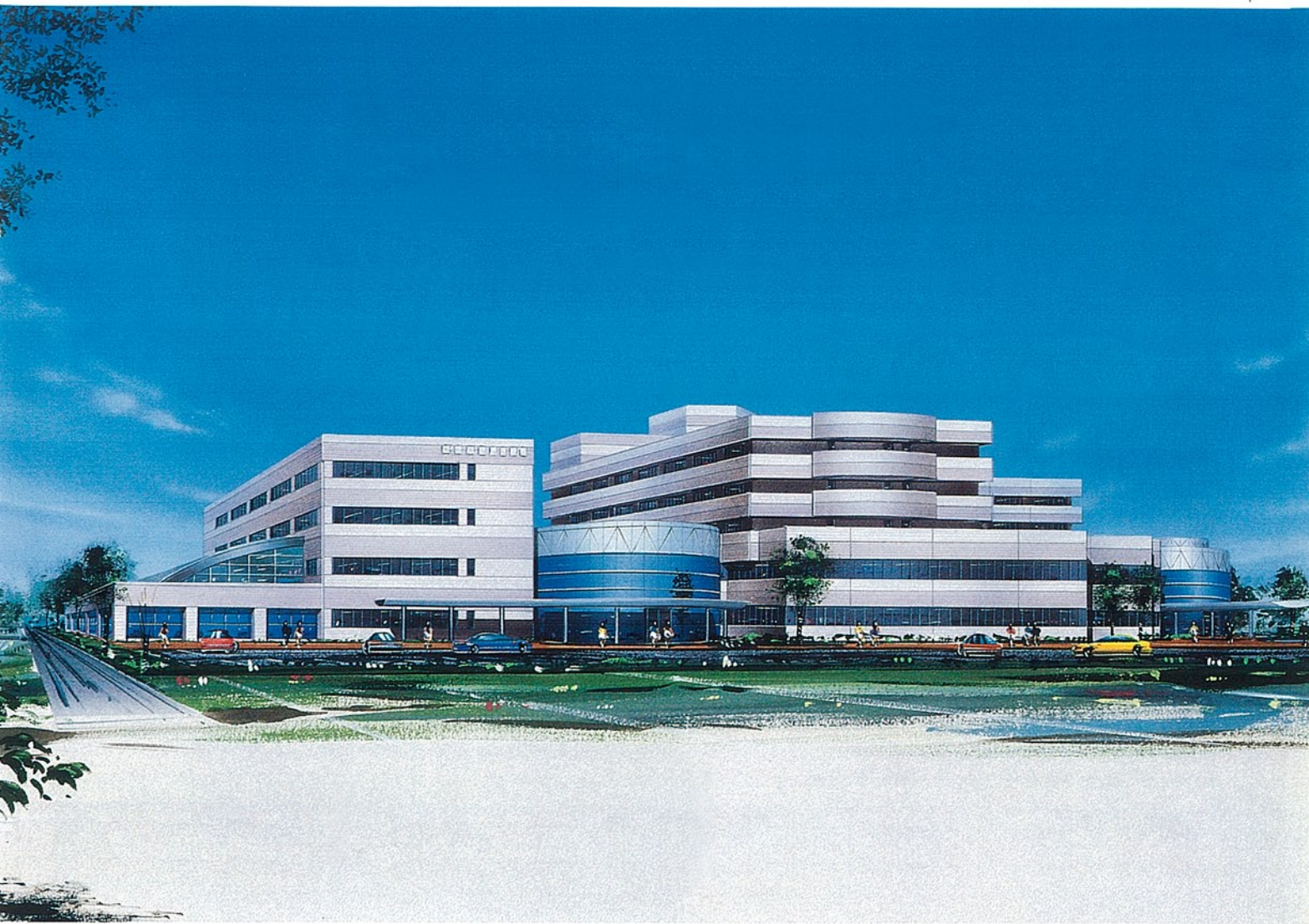
リハビリテーションセンター ●所在/金沢市赤土町 ●完成/H.6.8(予定) ●敷地/19,793㎡ ●構造/RC造:4F ●延床/4,355㎡
