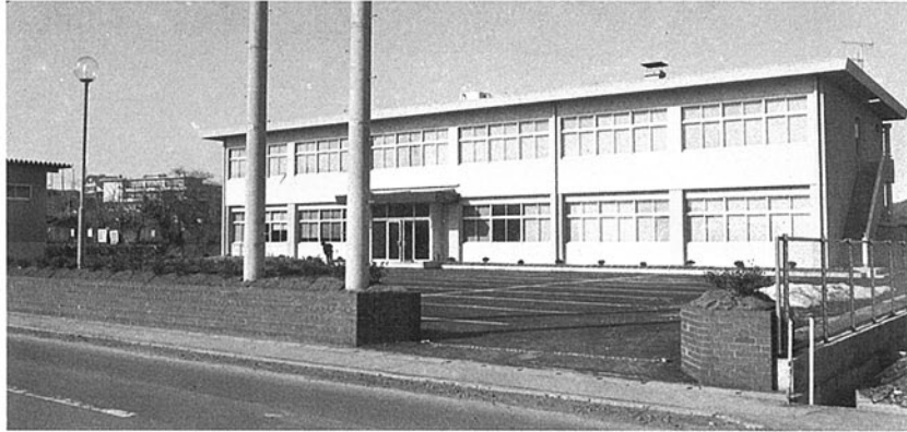
■珠洲保健所 珠洲市宝立町鶴島 ●竣工年度/S.49●構造/RC造 2階●延床面積/999㎡(1,159㎡)
