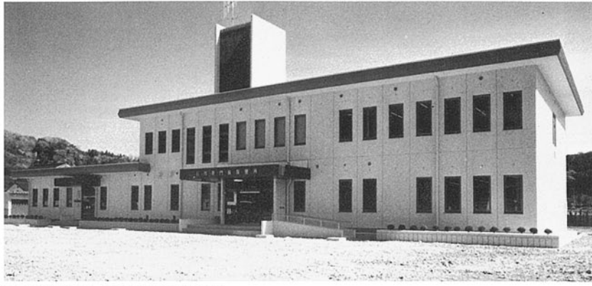
■門前保健所 鳳至郡門前町深田 ●竣工年度/S.53●構造/RC造 2階●延床面積/844㎡(1,067㎡)
