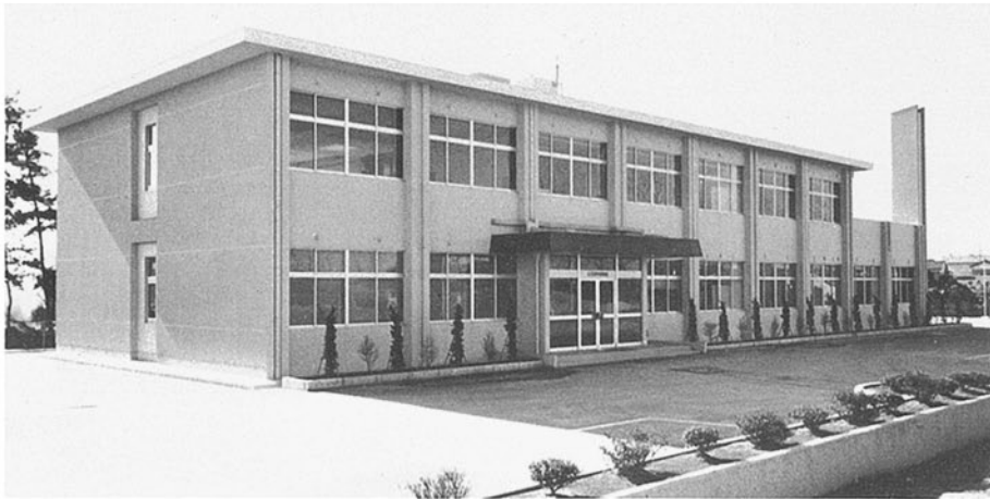
■羽咋保健所 羽咋市旭町 ●竣工年度/S.47●構造/RC造 2階●延床面積/949㎡(1,090㎡)
