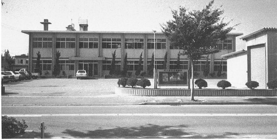
■松任保健所 松任市馬場町 ●竣工年度/S.48●構造/RC造 2階●延床面積/993㎡(1,136㎡)
