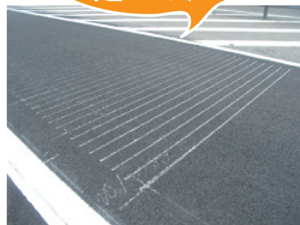
道路面に刻まれた溝
